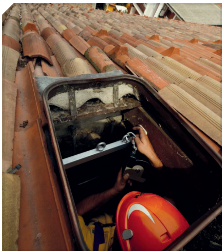
Fissaggio all'Abbaino, per lavoro sul tetto
